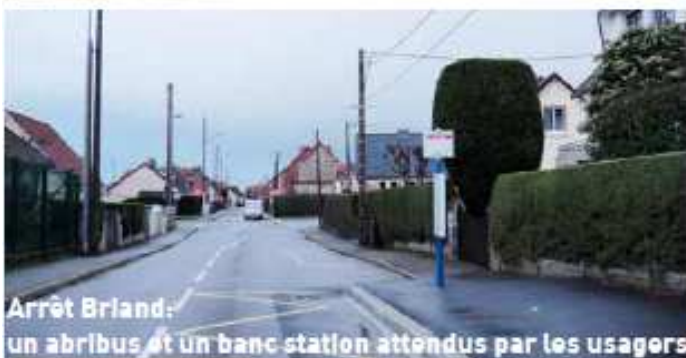
Arrêt Beau-Soleil équipé
